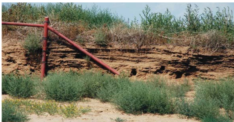
شکل ۶-۲۲. فرسایش بادی این دیواره را تنها چند سال پس از ساخت آن پوشانده است.
